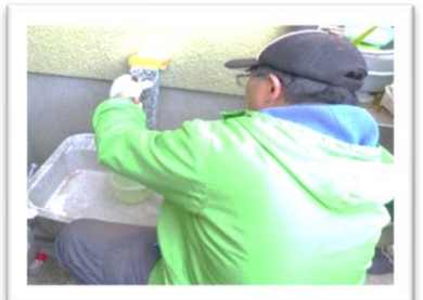
(水道パッキンの交換)
